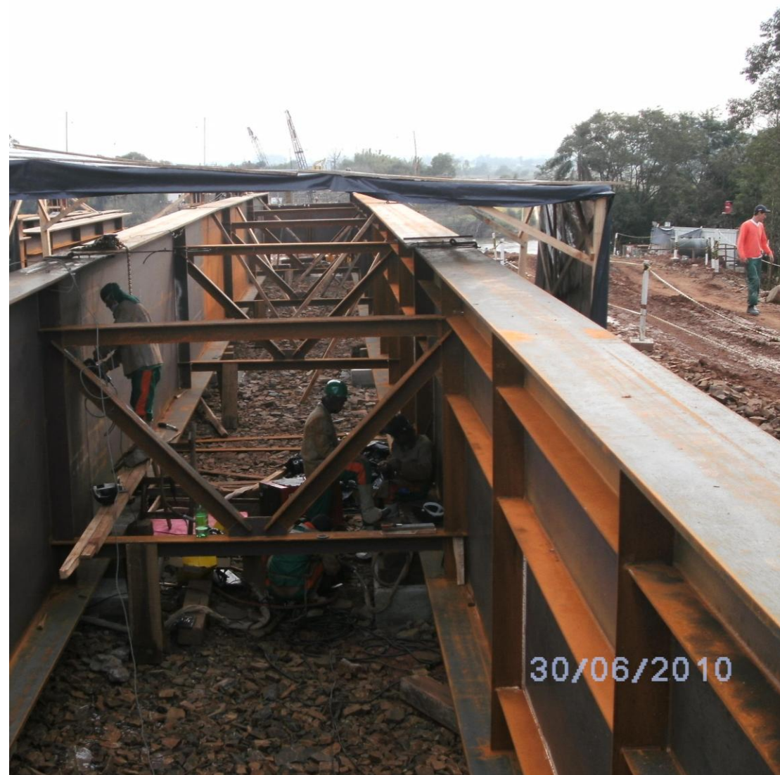
CONFEÇÃO E LANÇAMENTO DAS VIGAS METÁLICAS
