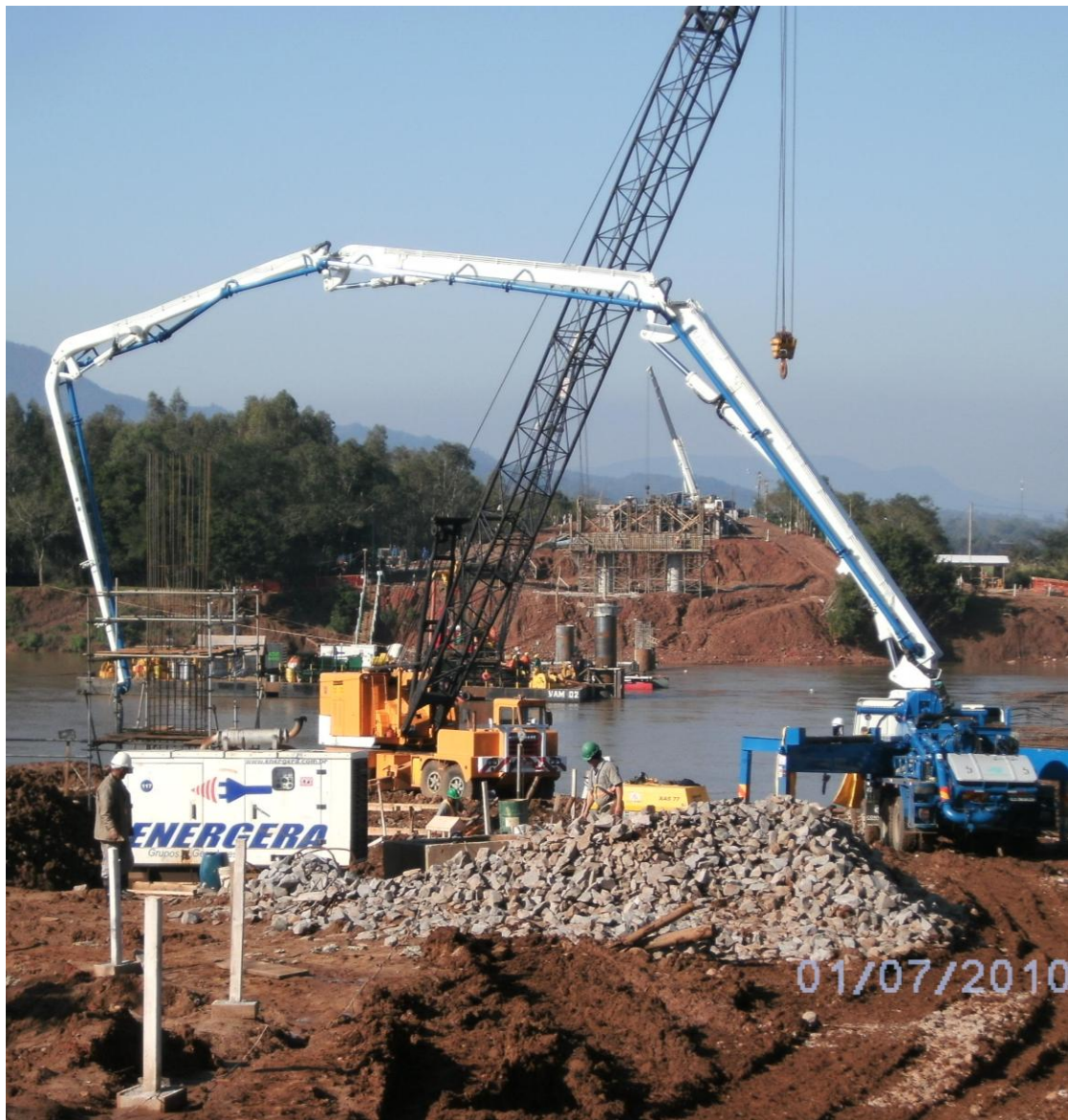
EXECUÇÃO DA MESOESTRUTURA
